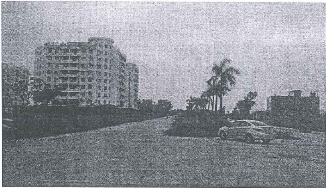
Hạ tầng khu đô thị giai đoạn 1 (Nguồn: CTCP Xây dựng 1369)
